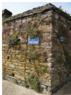
Vieux mur à Saint-Segal.
